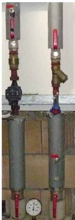
Obrázek 3: Stávající uzel pro VZT – DEMONTOVAT VYVAŽOVACÍ VENTI DN25
